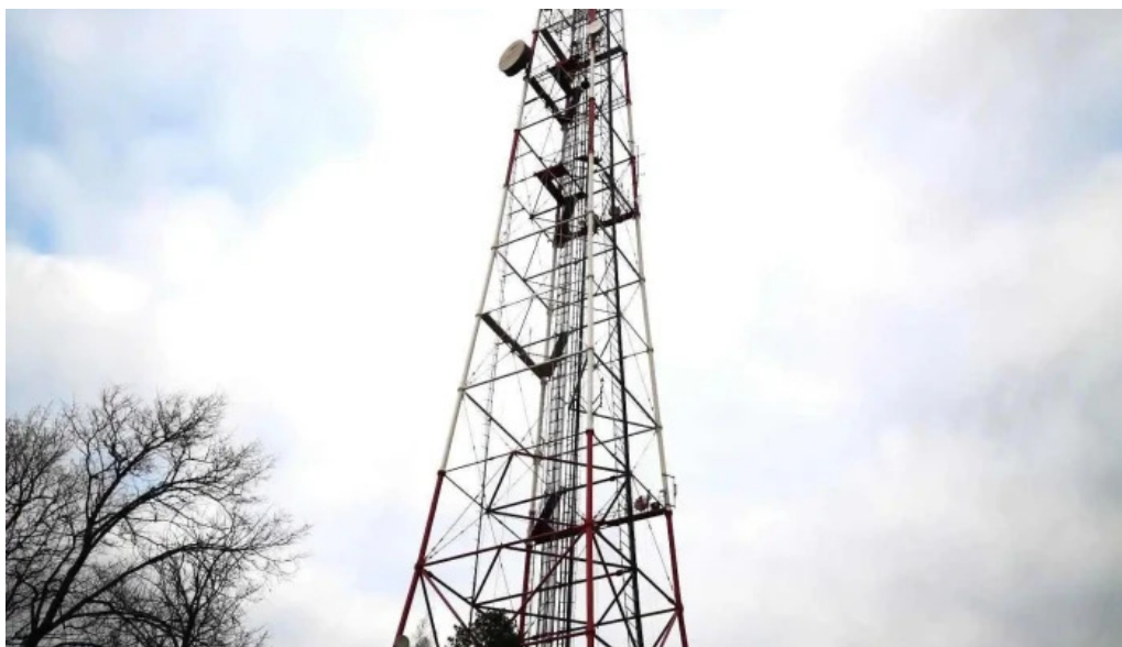
Cesvaines televīzijas tornis visi
