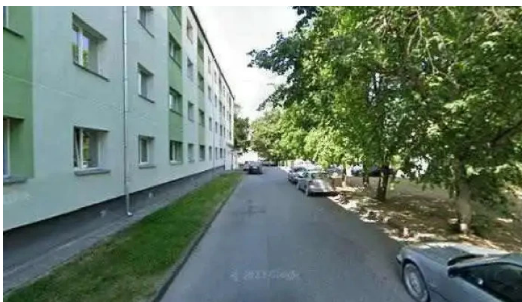
Elektrikis ielas attels un 360deg
