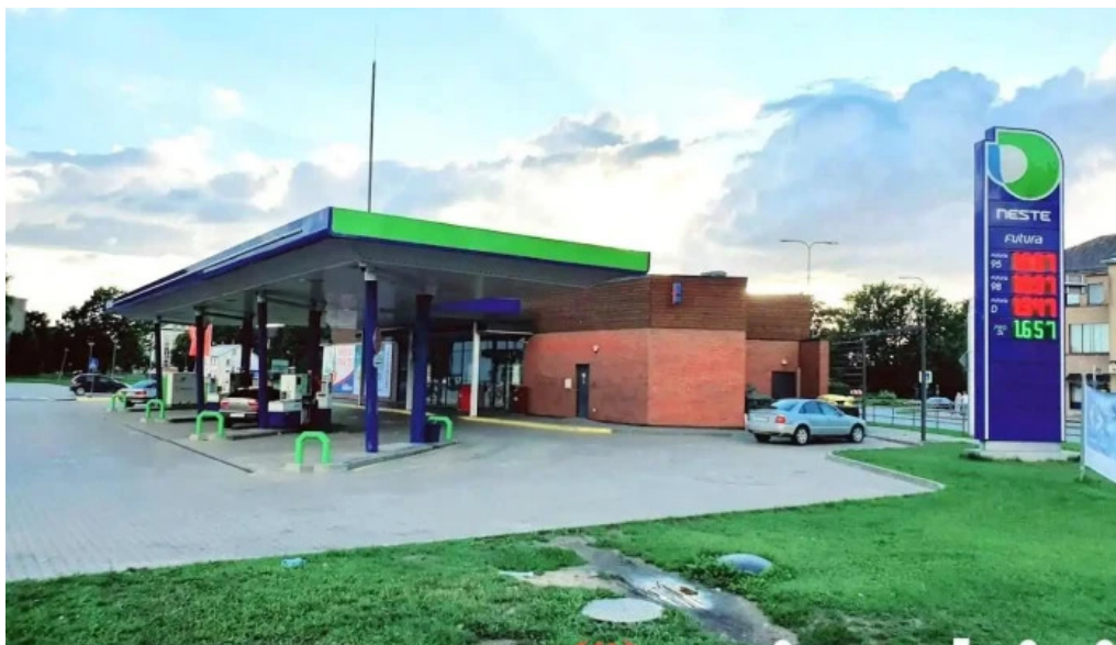
Neste bauska i dus bauska
